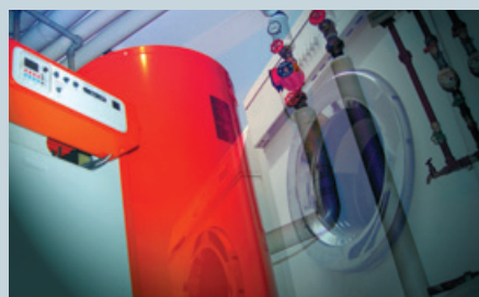
Nachrichten über Störungen, wie Wasserschäden, Strom- und Heizungsausfälle.
