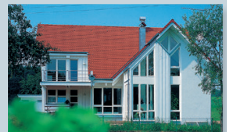
Steuern von Heizung, Warmwasser und Licht in Einfamilienhäusern.
